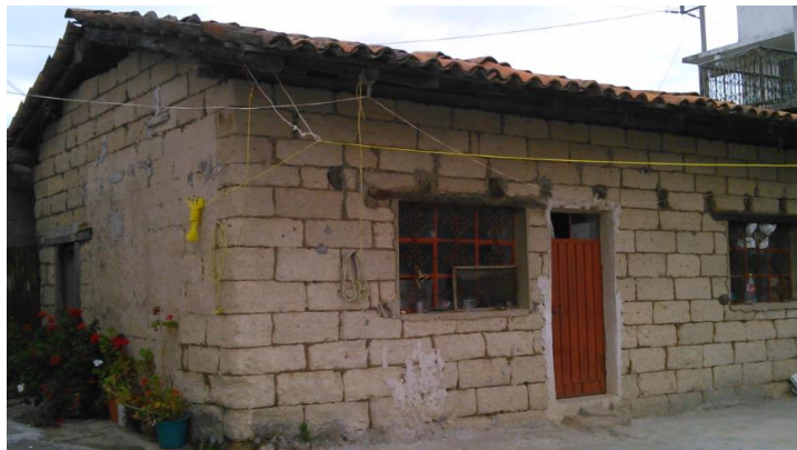
Foto 56. Granero construido con bloc de adobe actual, San María La Loma.
